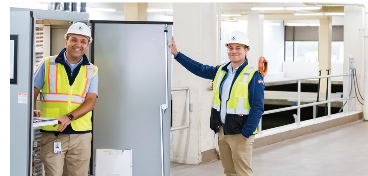
El personal de tecnología informativa mantiene la infraestructura tecnológica de la Comisión, incluidos los sistemas operativos de la planta de tratamiento de agua West Parish Filters.
