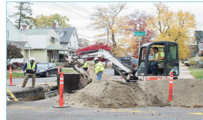
Los equipos de la Comisión reemplazan una tubería principal de agua en la Calle Milford en Springfield. (Ver arriba). El financiamiento de WIFIA apoyará proyectos de mejora de tuberías principales de agua adicionales dentro del sistema de distribución.
