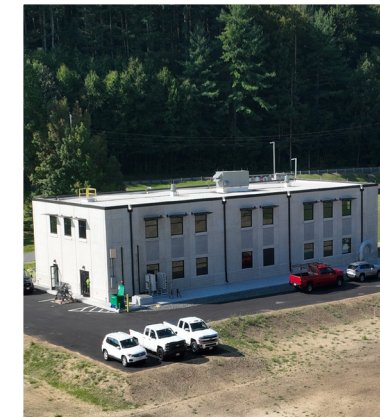
La nueva instalación de retrolavado en West Parish Filters se completó en el otoño de 2023.
