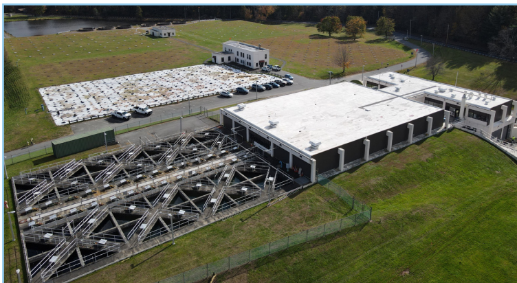
La planta de tratamiento de agua potable West Parish Filters en Westfield, MA fue construida originalmente en 1909 y modernizada por última vez en 1974.
