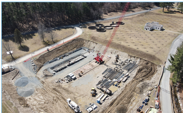
En 2021, la Comisión inició la construcción de una nueva era de tratamiento de agua potable en West Parish Filters. La construcción de la fase 1 de la nueva planta de tratamiento de agua está actualmente en marcha, con la construcción del nuevo proyecto de reemplazo de la estación de bombas de Clearwell y Backwash. Los filtros de arena lenta originales de 1909 fueron demolidos para dar paso a Clearwell.
