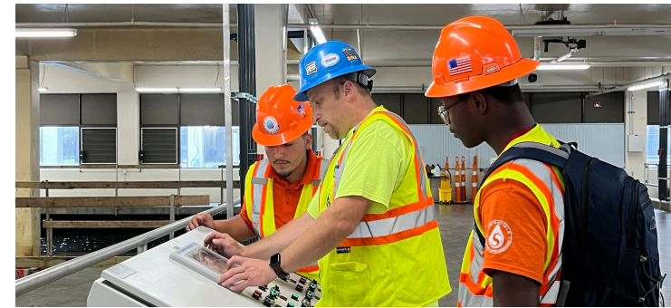
Los pasantes de tuberías aprenden las operaciones de la planta de tratamiento en West Parish Filters de la mano de un miembro del equipo de Operaciones de Agua de la Comisión.
