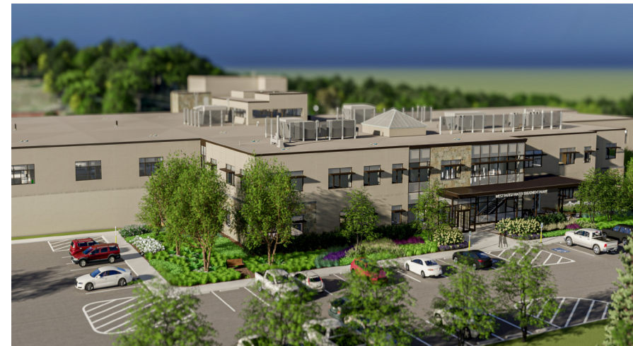
Representación de la nueva Planta Potabilizadora de West Parish (Hazen y Sawyer).
