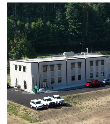
La nueva instalación de retrolavado en West Parish Filters se completó en el otoño de 2023.
