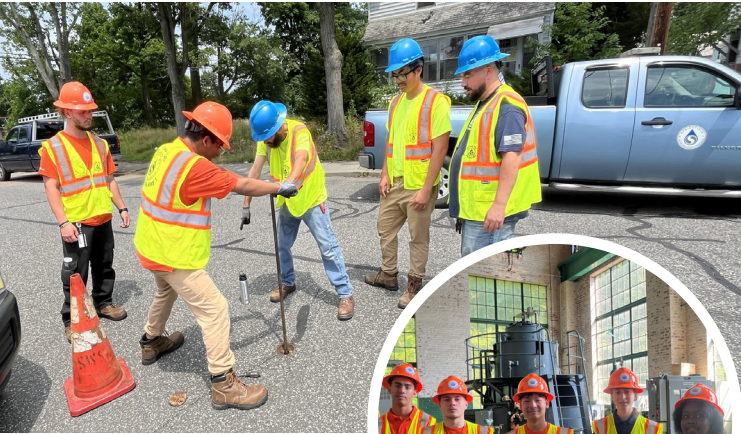
Los pasantes adquieren experiencia práctica con las operaciones de válvulas en el sistema de distribución de agua potable.
