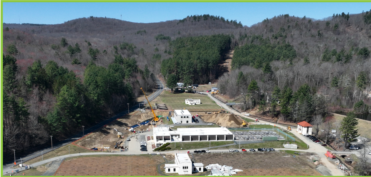
Construcción de la nueva Planta de Tratamiento de Agua West Parish en esta en el sitio de la planta existente en Westfield, Massachusetts, abril de 2026.
